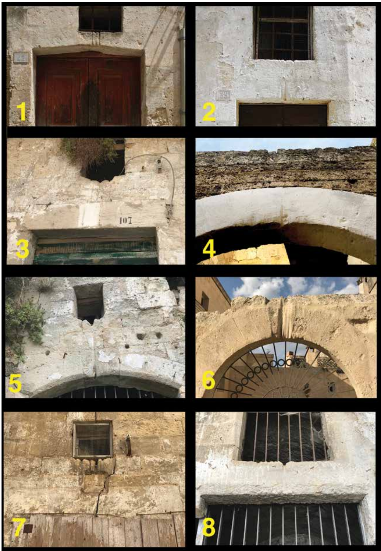
Fig. 1 - Alcune delle architravi presenti nei Sassi di Matera che presentano i solchi verticali oggetto di questo studio. 1 - Vico Sen Leonardo; 2 - Vico Casalnuovo; 3 - Via San Pietro Barisano; 4 - Via Tre Corone; 5 - Rione Malve; 6 - Via San Gennaro; 7 - Recinto Paradiso; 8 - Via Tre Corone. Riquadri 1 e 2 Foto di Alessandro Castano; Riquadro 5 Foto di Raffaele Paolicelli; Restanti riquadri Foto di Francesco Foschino
